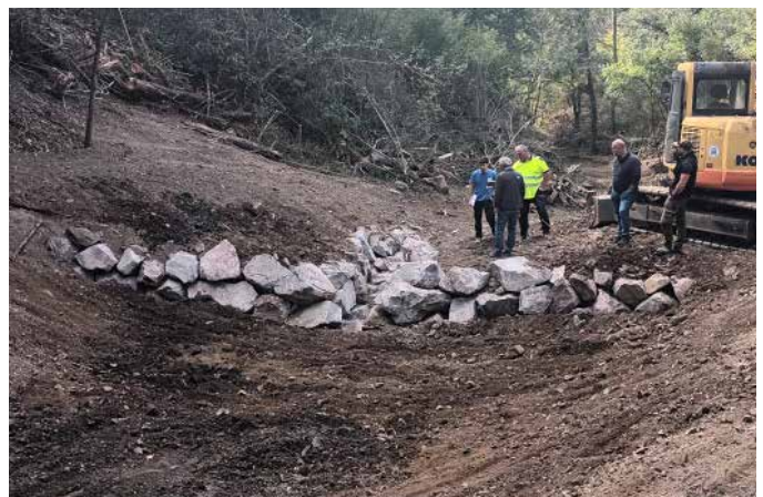
Un piège à gravier et un enrochement pour l'écoulement de l'eau.
