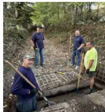
Nettoyage des rigoles rue des Fleurs.
