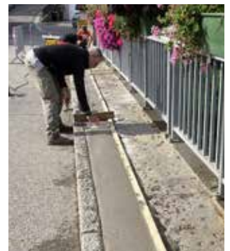
Réfection du trottoir du pont de la Thur.
