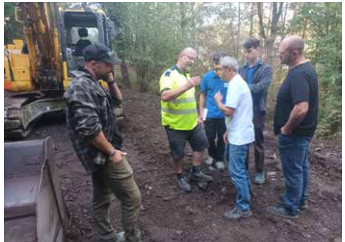
Réunion de chantier au sommet.
