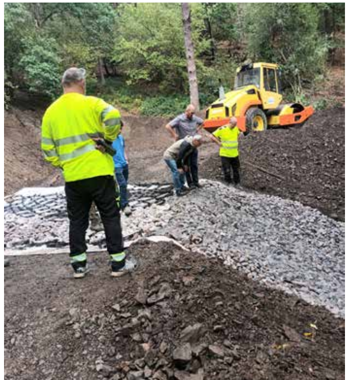
Le lit de concassés sur le talus du chemin DFCL.
