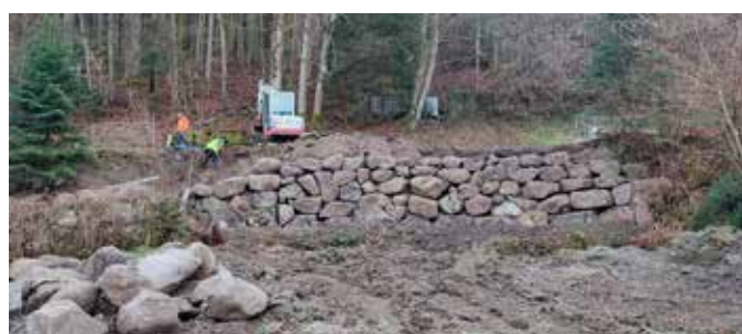
Gros chantier en amont du camping. Sécurisation du chemin par un enrochement impressionnant.
