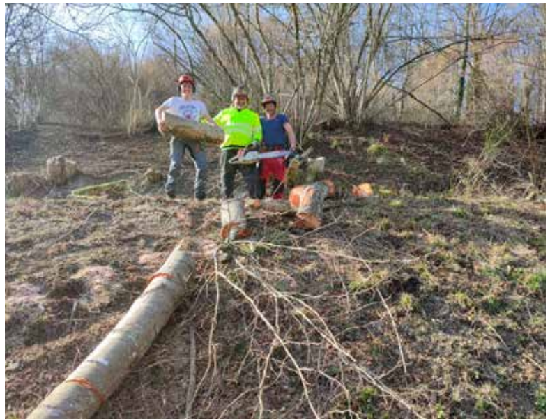
Le service technique a sécurisé la montée de Geishouse dans sa partie mooschoise en supprimant les arbres dangereux.
