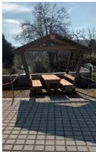
Le chantier de la cour de récréation de l'école maternelle.
