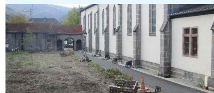
Chantier de pavage au pied du mur de l'église de Moosch
